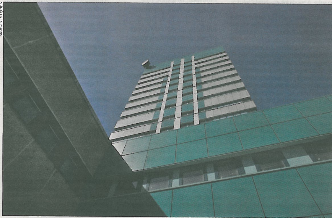
Na początek kliniki zajmą dziewięć z 17 pięter budynku
